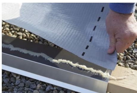
Monter herefter undertag på tagfod.
